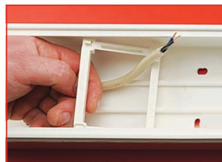
Разместите внутри корпуса фиксатор рамки (защелками наружу) и пропустите через него кабель
