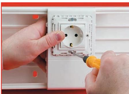
Электроустановочное изделие в корпусе с посадочным размером 60 мм фиксируется в рамке при помощи 2-х винтов-саморезов, поставляемых в комплекте с рамкой PDA-N
