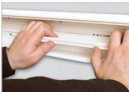
Разделитель защелкиванием устанавливается на направляющие дна короба
