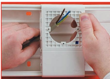
Рамка PDA-N с фиксатором монтируется в корпус защелкиванием аналогично рамке PDA, монтаж которой описан ранее
