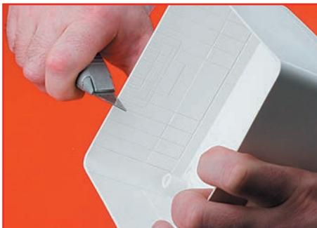
Вырежьте в крышке коробки по перфорации проемы под соответствующий размер канала
