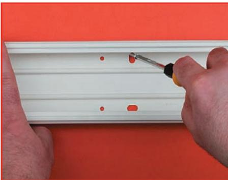
Короб крепится к стене на винтах-саморезах через перфорацию на основании (крепеж см. в разделе "M5 Combitech").
