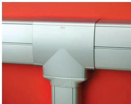
Защелкиванием установите накладку на тройник. Затем крышки коробов сдвиньте в сторону тройника или переустановите их заново, чтобы они зашли под накладку
