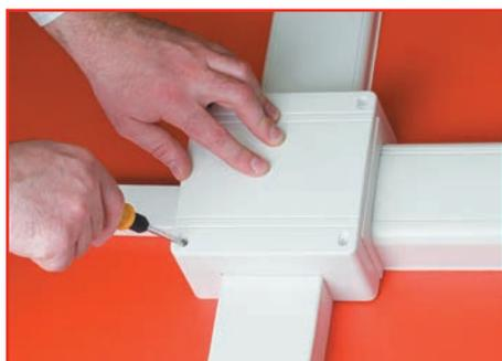
Установите крышку коробки и прикрутите ее к базе винтами
