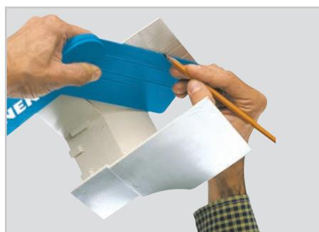
При углах больших или меньших чем 90° необходимо обрезать часть элемента угла
