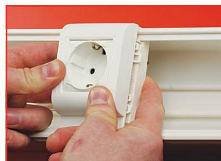
Придерживая рамку, потяните на себя фиксатор и защелкните его с внутренней стороны корпуса
