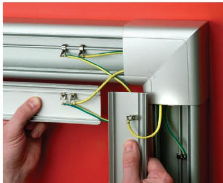
Количество монтируемых проводов заземления в плоском угле
